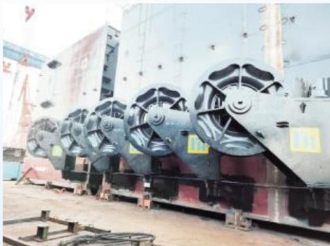
大连造船建造的FPSO-10项目艉段与平形体对接完成
